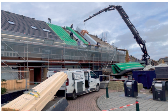
Cellostraat in uitvoering
