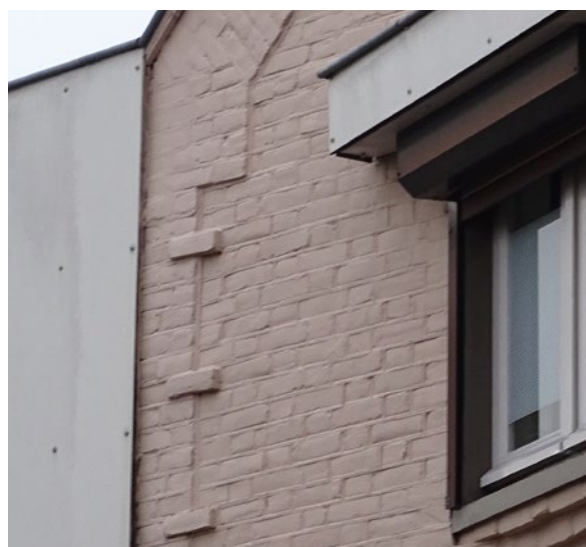
Figuur 4.2 Baksteendetails in de gevel
