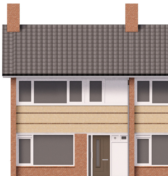
Voorzijde na renovatie
